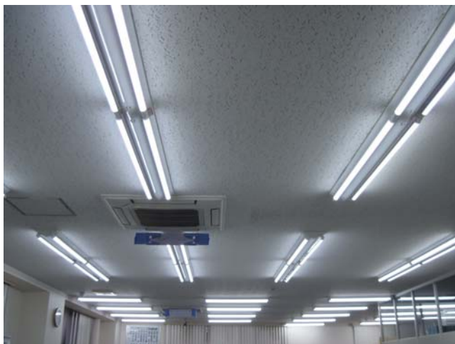
常時使用する40Wタイプ蛍光灯を全てLEDに交換しました
